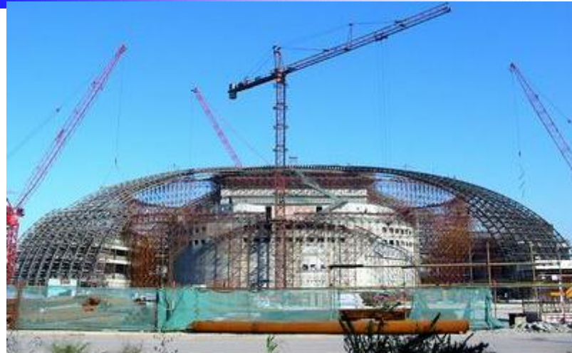
国家大剧院的半椭圆型钢结构壳体
